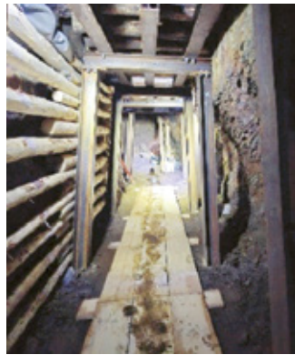
nachher: Stahlausbau
