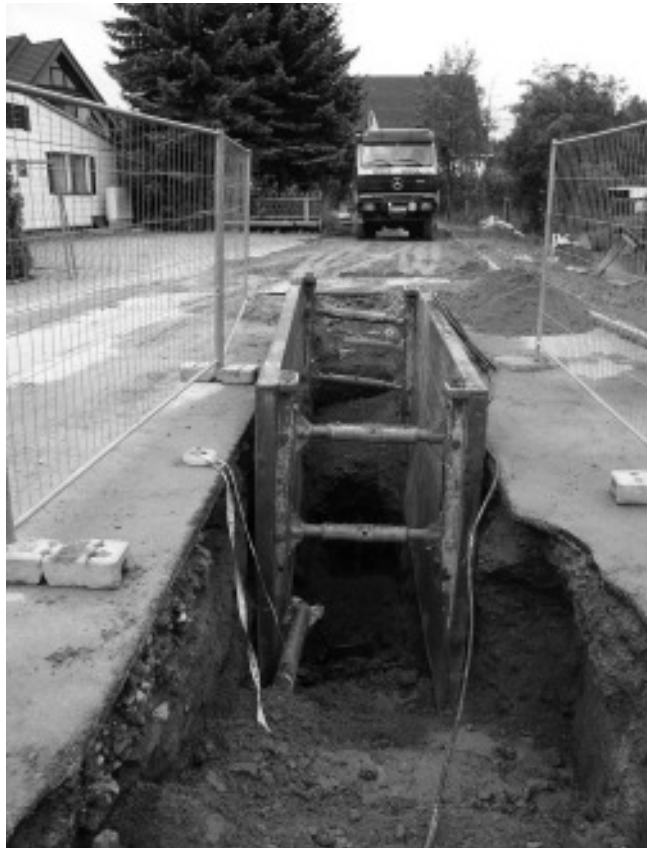
Kanalbau und Verlegung der neuen Trinkwasserleitung in der Nähe der Arztpraxis
